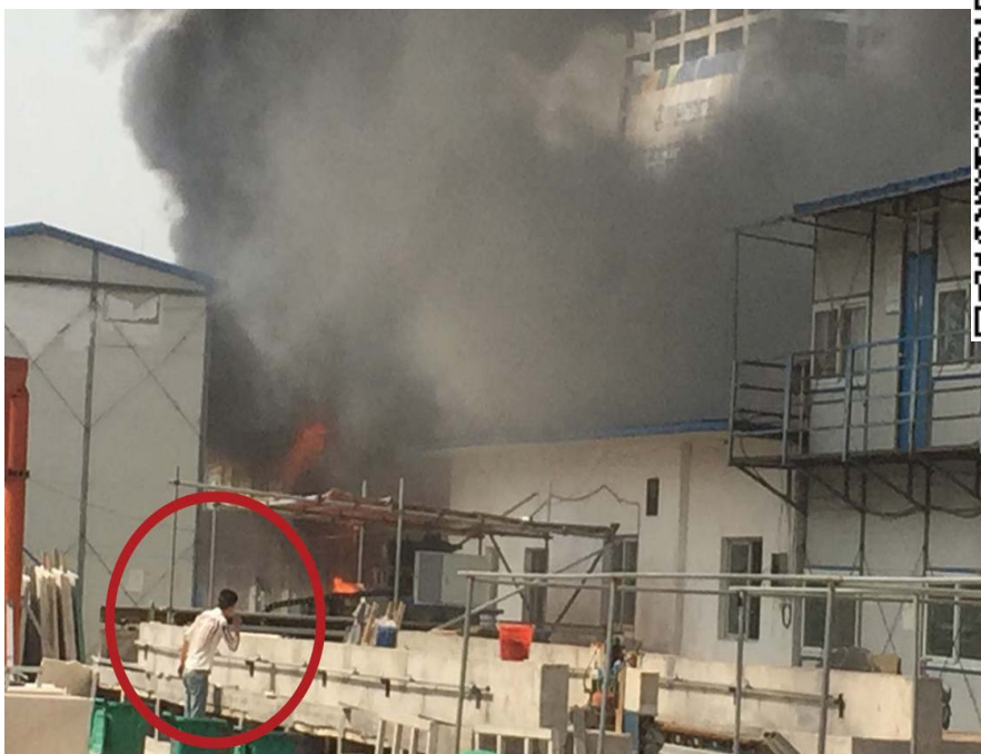
板房起火浓烟滚滚,一名农民工还在淡定刷牙围观。
