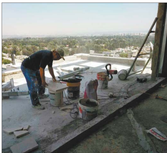
以色列一处工地上的中国工人在工作。展茂林 供图
