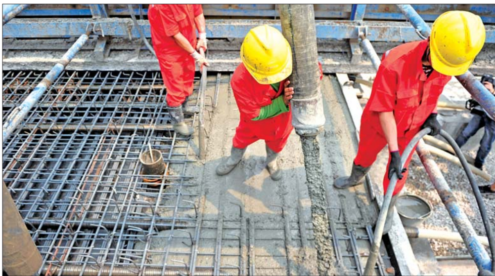
20日,在中铁十四局济南轨道交通R1线U梁场,施工人员正在浇筑最后一块U梁。本报记者 王媛 摄
