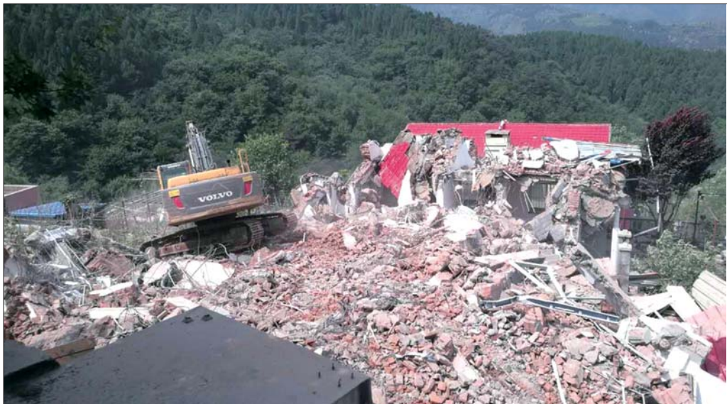
21日,青龙峪别墅群拆违现场。
