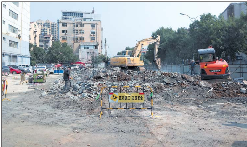
凯贝特大厦前的建筑垃圾开始清运。
