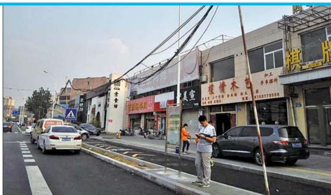
整治前的土屋路空中布满“蜘蛛网”。
