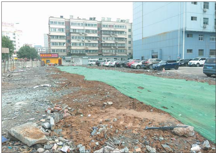
凯贝特大厦前的拆违垃圾基本清运干净。
