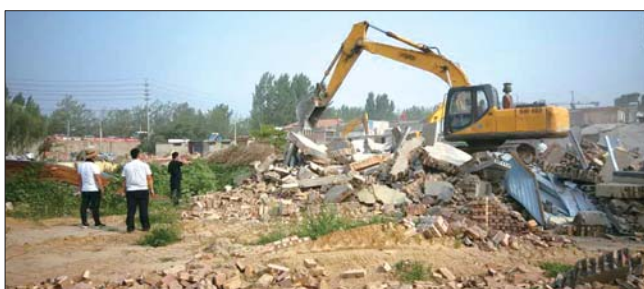
挖掘机正在拆除违章建筑。本报记者 邢孟 摄
