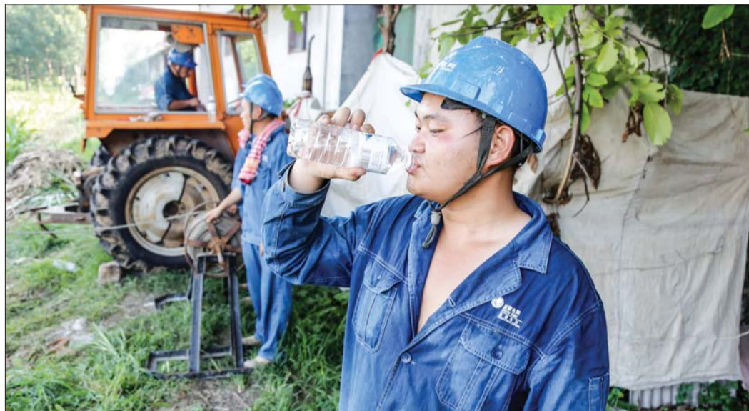
室外作业出汗太多，电力施工人员补水。本报记者 李岩松 摄
