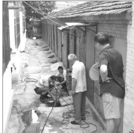
修复管道。 本报见习记者 王雅春 摄
