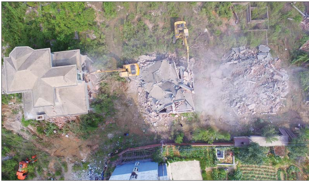
13日,济南南山管委会组织人员拆除了南部山区17栋别墅。本报记者 周青先 摄
