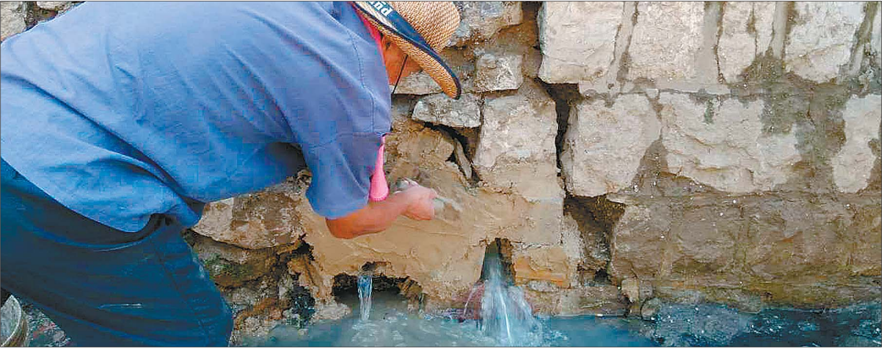
工人正在封堵万盛大沟万盛北街河段污水管道。
