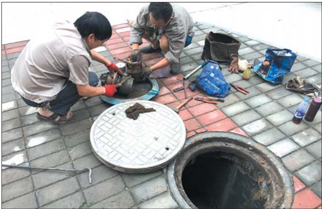
检修人员正在清理平衡阀上的铁锈。 本报记者 张帅 摄
