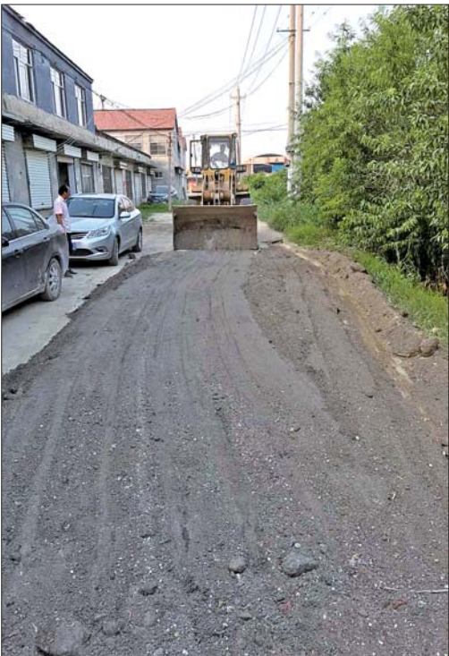
利用小散乱污企业的水泥灰渣铺平西王村进村道路。
