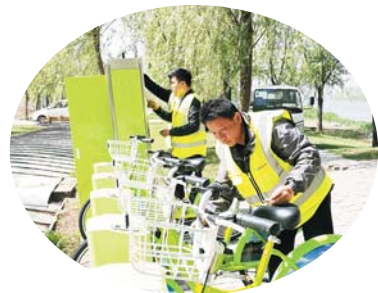
减河景区公共自行车安装调试
