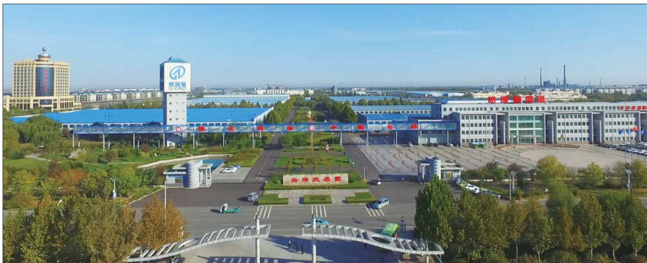
格瑞德集团中央空调产业园
