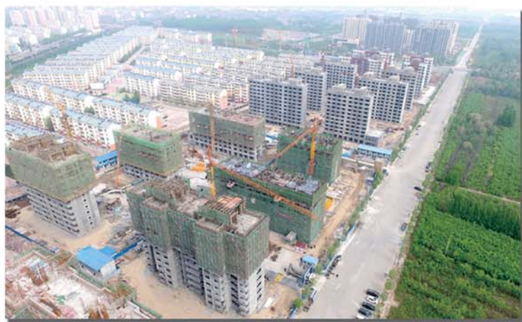
正在建设中的平原县棚改安置小区。
