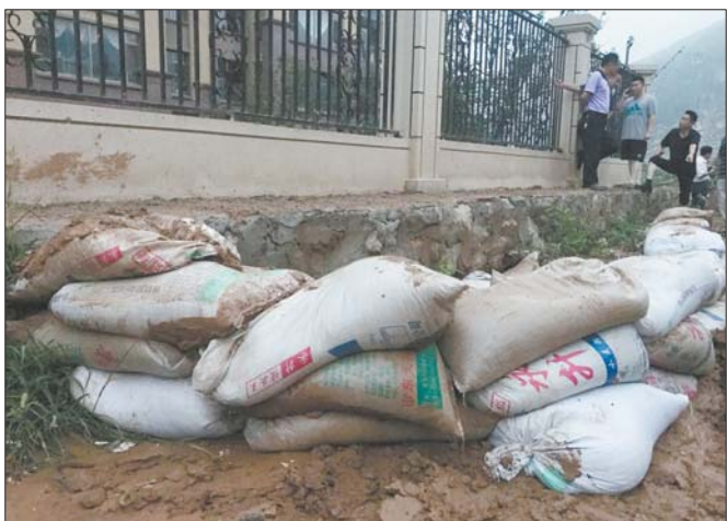
领秀城小区进水口已经被沙袋堵死。 本报记者 唐园园 摄
