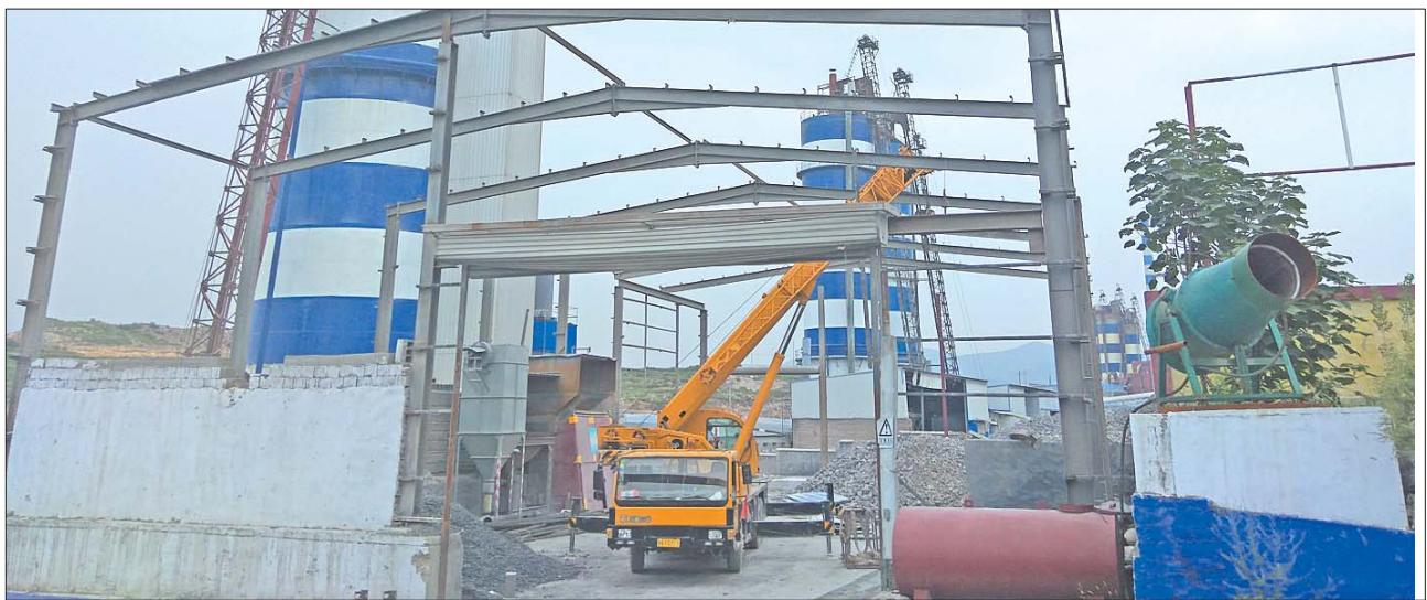
一座石灰窑正在自拆中。 本报记者 蒋龙龙 摄
