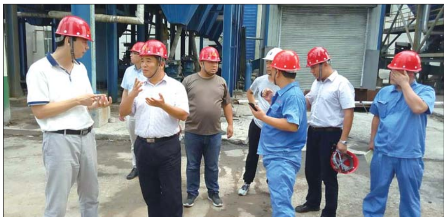
◀ 济南热力集团领导参观施工现场。 通讯员 于共超 摄
