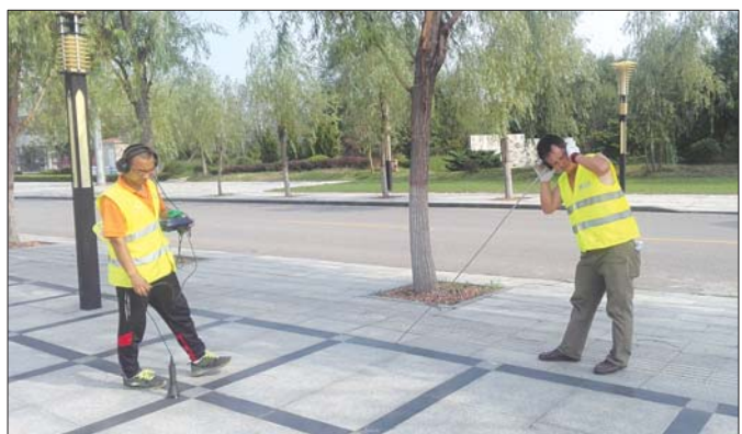
专业公司对供水管道检测维修。本报记者 李云云 摄
