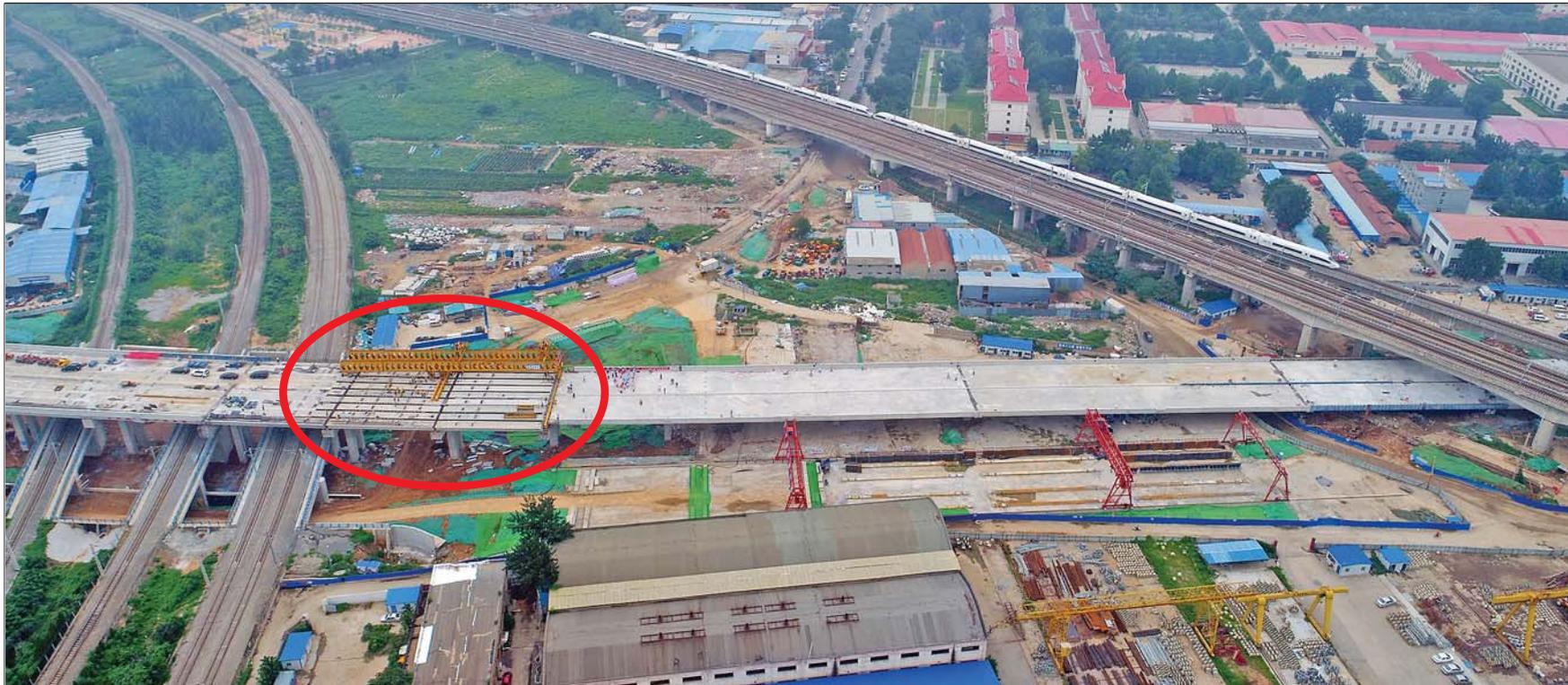
2日上午10时,济南二环西路高架桥施工现场,最后一根箱梁安装完毕(红圈处),至此,由中铁十局承建的二环西路高架桥南延穿越铁路工程箱梁全部架设完成。记者按下快门时,恰巧右上方的铁轨上有一列高速列车驶过。本报记者 王媛 摄
