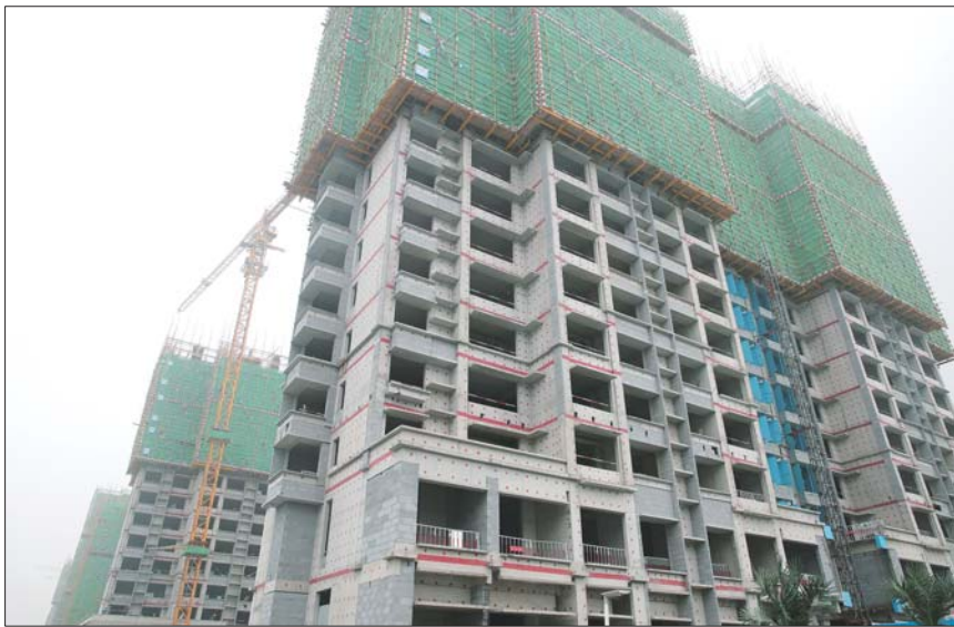
丁家村安置房项目建设现场。
