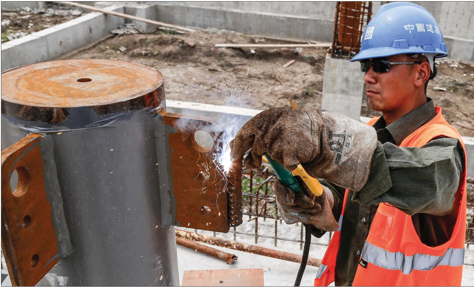
汤海洋戴着厚手套焊接建筑构件。
