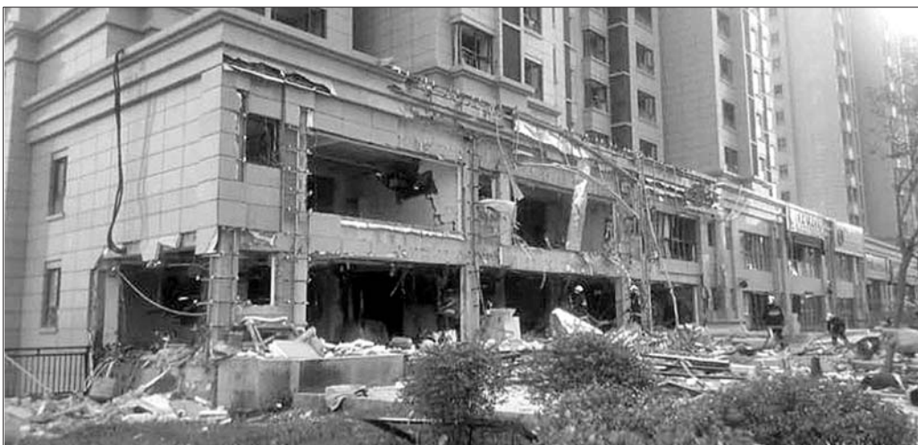
7月26日早上7点左右,济南银丰唐郡荷花园15号楼一饭店煤气泄漏发生爆炸,附近商铺门窗破损严重。(资料片)
