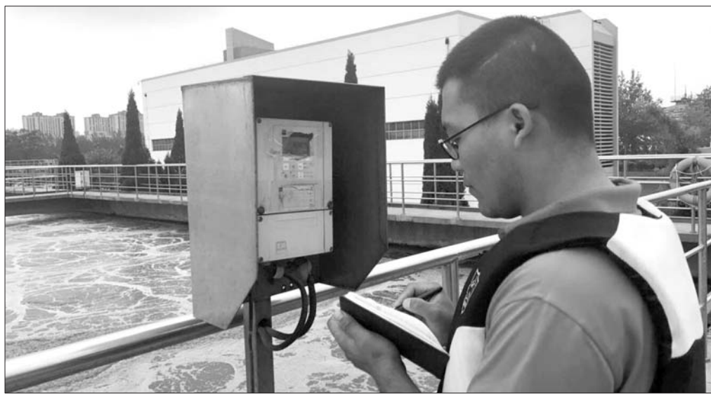
工作人员在比对生化池溶解氧浓度。 本报记者 马玉姝 摄
