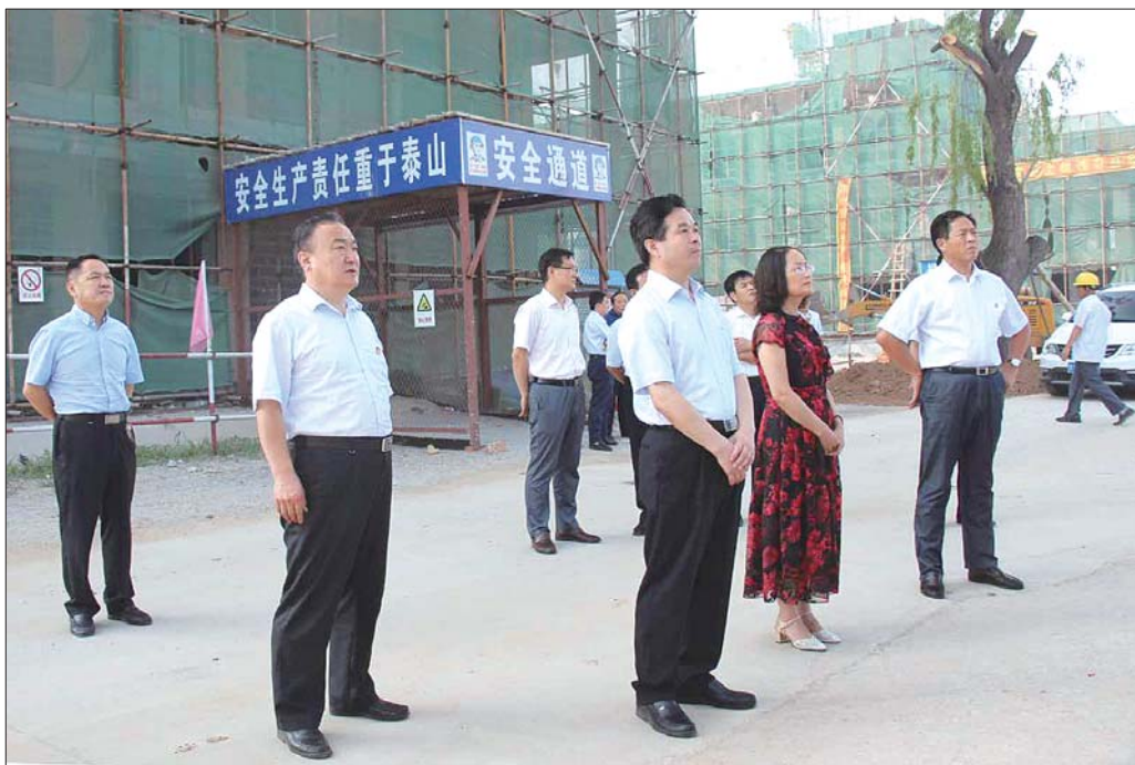
潍坊市人大常委会副主任、临朐县委书记顾建华检查学校建设。
