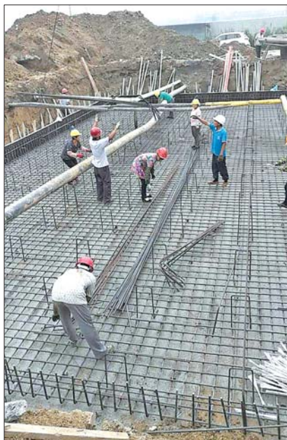
工程正紧锣密鼓地进行中。
