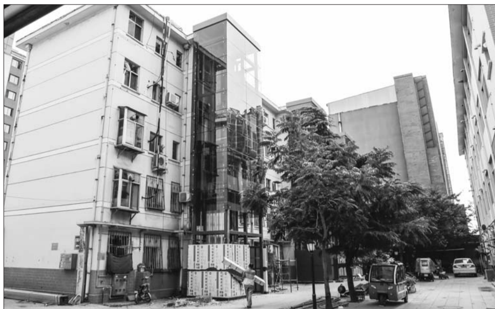
如意家园小区内加装的电梯即将完工。 本报记者 李岩松 摄
