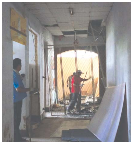
灵山大街路口“小黄屋”门窗正在拆除。
