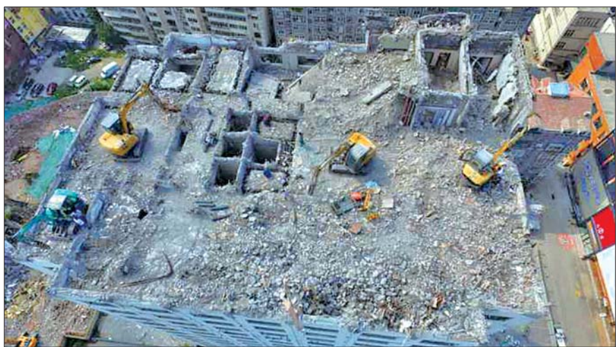
四台挖掘机被吊到了17层楼顶，进行拆除作业。 本报记者 周青先 摄
