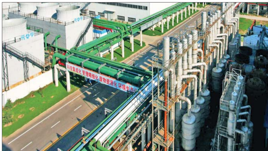
梁山菱花生态工业园厂区一角。
