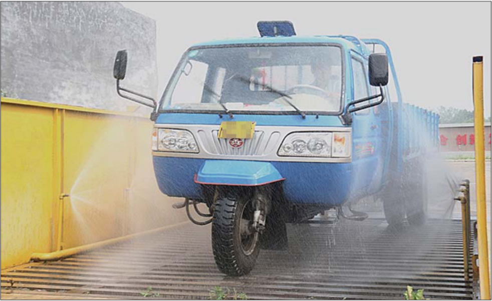
出堆场前,自动喷淋设施将车辆冲洗干净。
