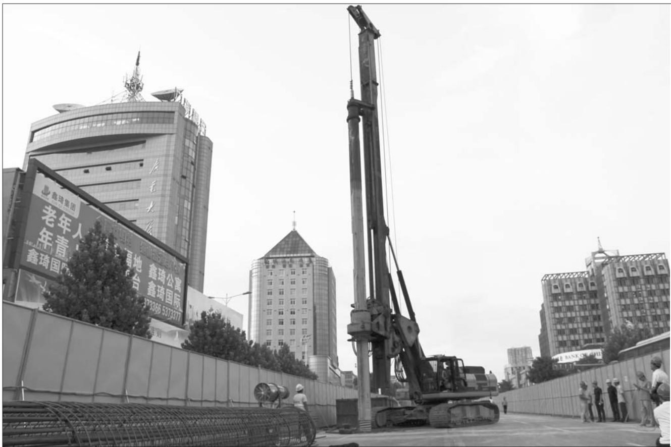
孔孟旅游快线完成桩基146个。本报记者 朱熔均 摄
