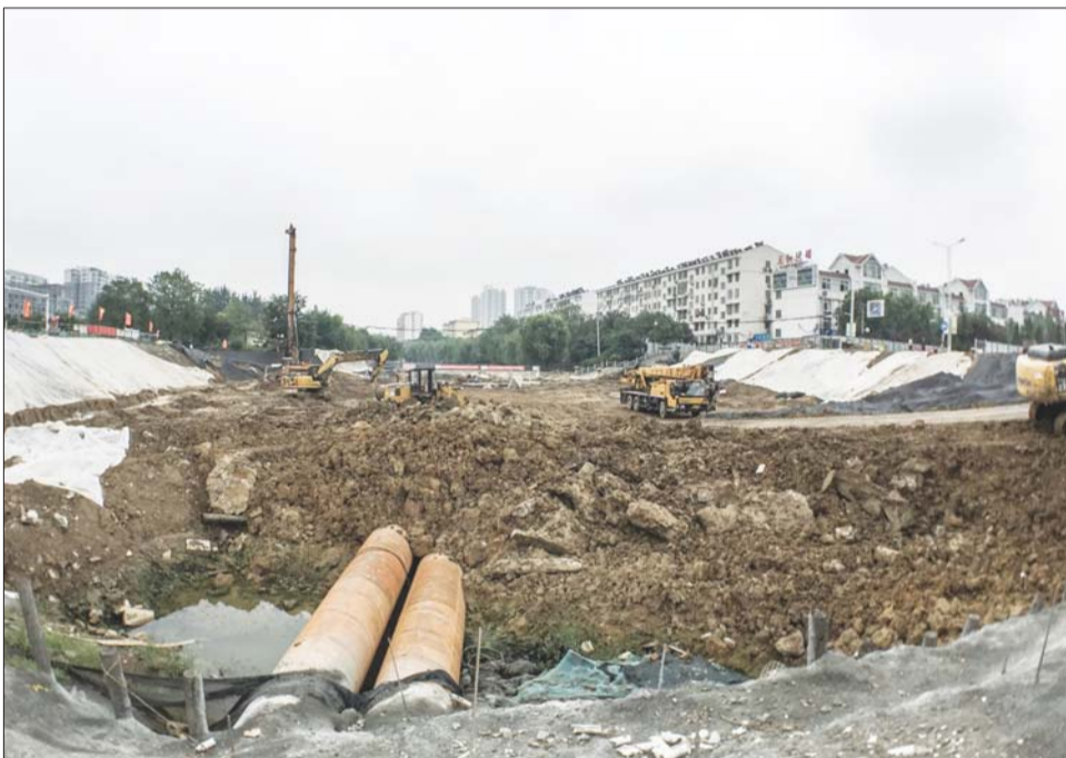
济安桥老桥已拆除,新桥正在建设中。 本报记者 李岩松 摄
