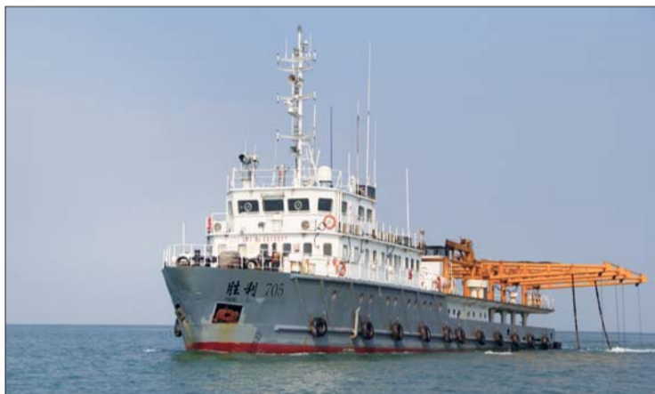
在孟加拉湾进行作业施工。
