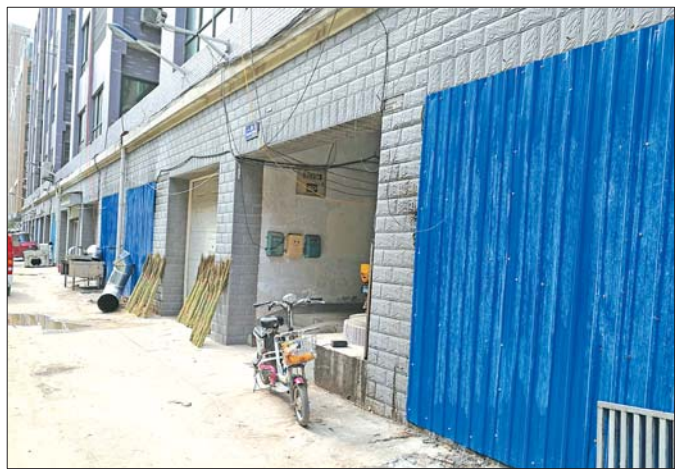
餐饮业户的烟灶以及相关设备被拆除。记者 梁越 摄
