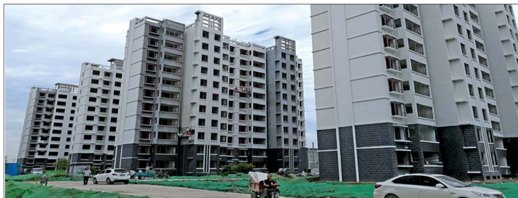
滨河社区一期9栋建筑已全部封顶。 记者 梁越 摄
