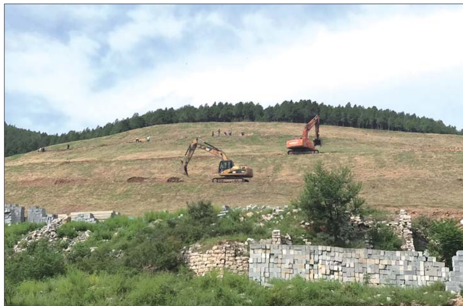
渣土山上,二十多位工人和三辆挖土机正在工作。
