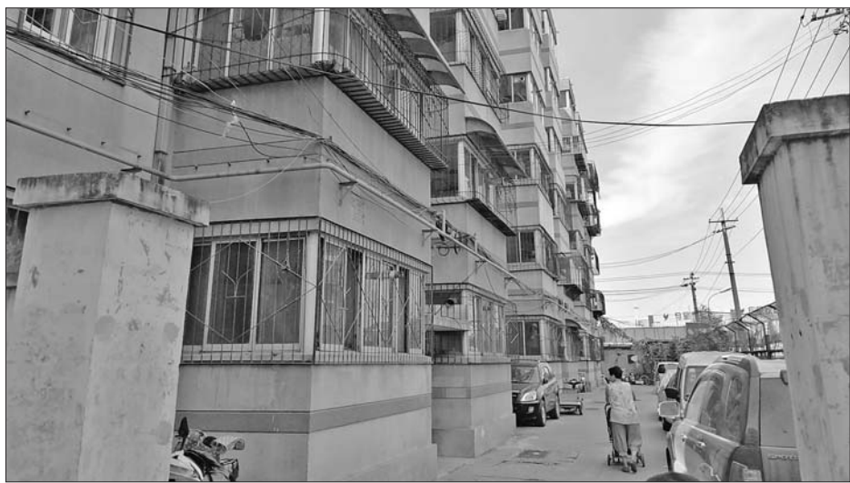
位于金牛小区的事发居民楼。
