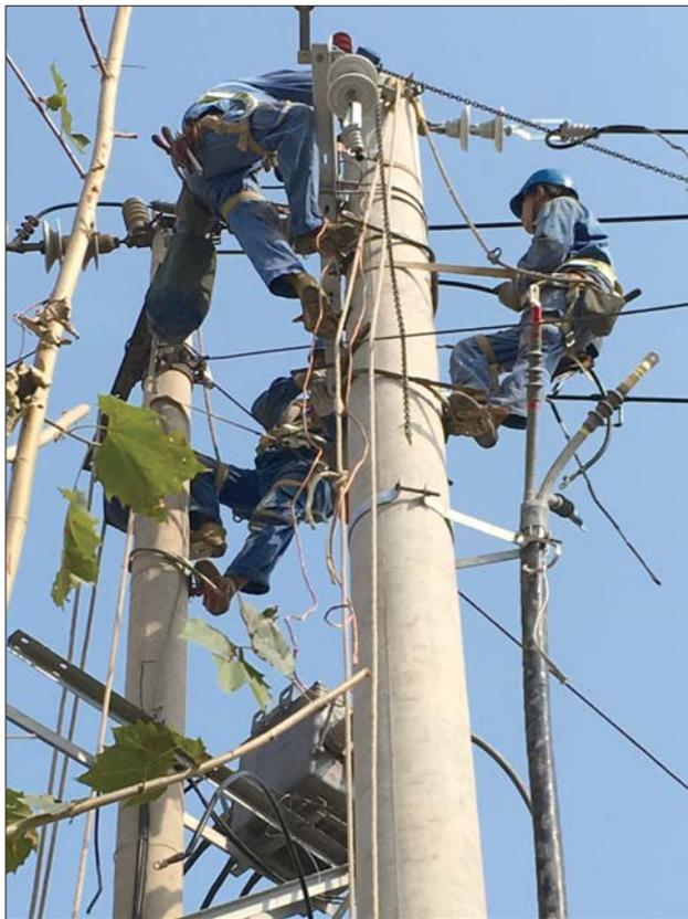
环山南路与燕子山西路交叉口东侧一处高压线上,电力工人们正在高空作业进行落缆施工。 本报记者 王皇 摄
