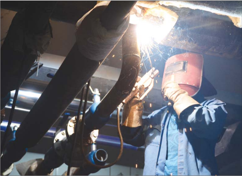
施工人员在切口处焊接分管网。 本报记者 孙璇 摄
