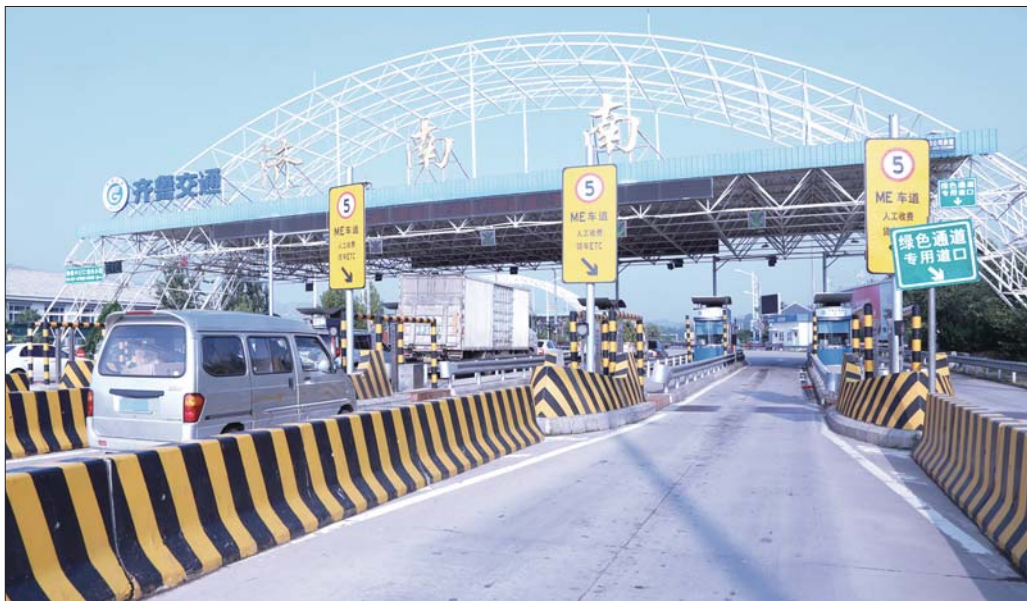
不停车移动支付系统在济南南绕城高速公路试运行,目前已顺利通过测试。 本报记者 刘相华 摄
