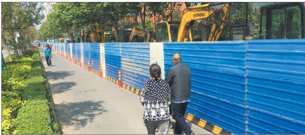
济南出台最严治尘令,施工工地要实现100%围挡。(资料片) 本报记者 王媛 摄
