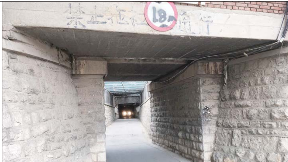
沿线东西向通行的最短距离处,仅有这样一个容一车通行的涵洞。
