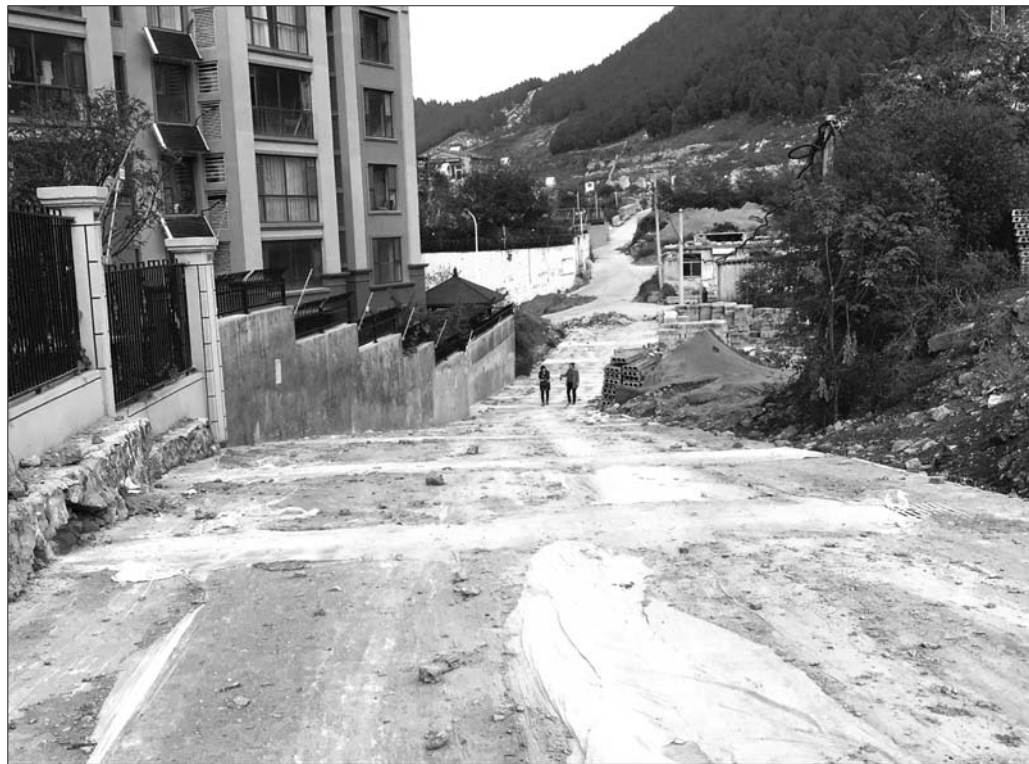
渣土山下的水泥路面基本铺完,因为部分水泥没有干透,还覆盖着塑料薄膜。 本报记者 王倩 摄
