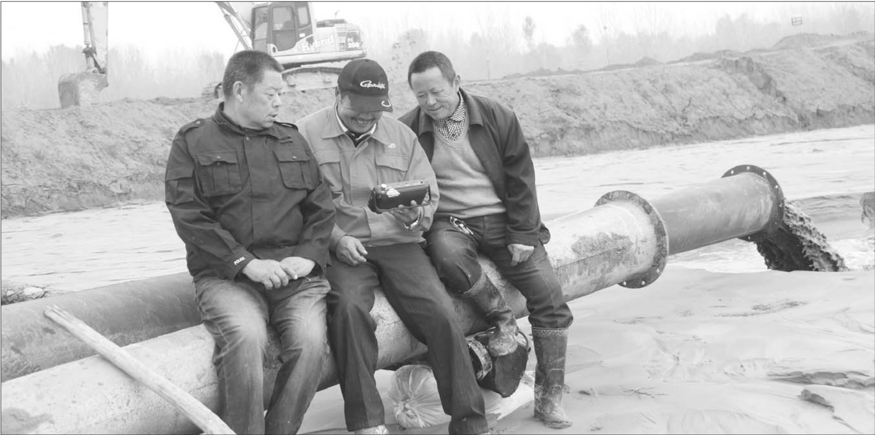
18日上午,在位于黄河滩区的菏泽东明县长兴集乡8号试点村台的施工现场,3名工人通过收音机收听十九大报告。 本报记者 李德领 通讯员 王恩标 摄影报道
