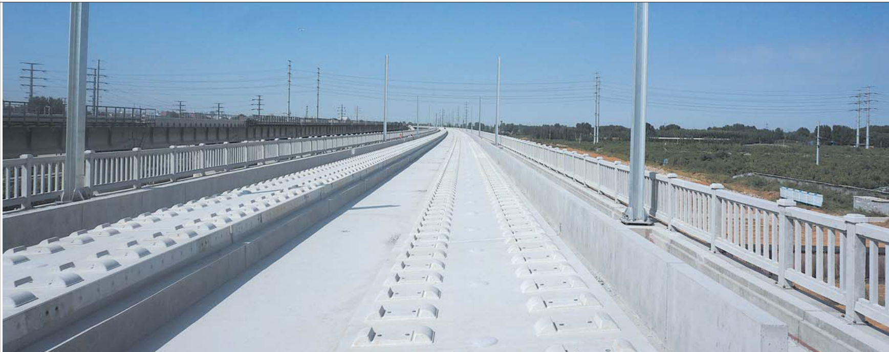
平整洁净的路基轨道犹如为高铁铁轨铺上了席梦思床垫。 本报记者 王皇 摄
