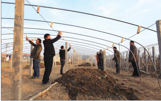
去年12月9日随志光请来扎棚技术工在新填造的土地上扎棚。
