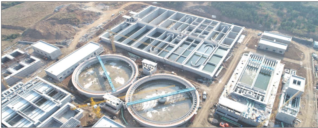
管理区八河污水处理厂日前开始试运行。该项目是我市民生重点工程项目之一。4万吨污水处理能力和20公里管网建设,可覆盖东山、王连两个街道和工业园周边60多个村,300多家企业,出水水质达到一级A标准。该项目被推介为山东省第三批31个政府和社会资本合作(PPP)示范项目。
