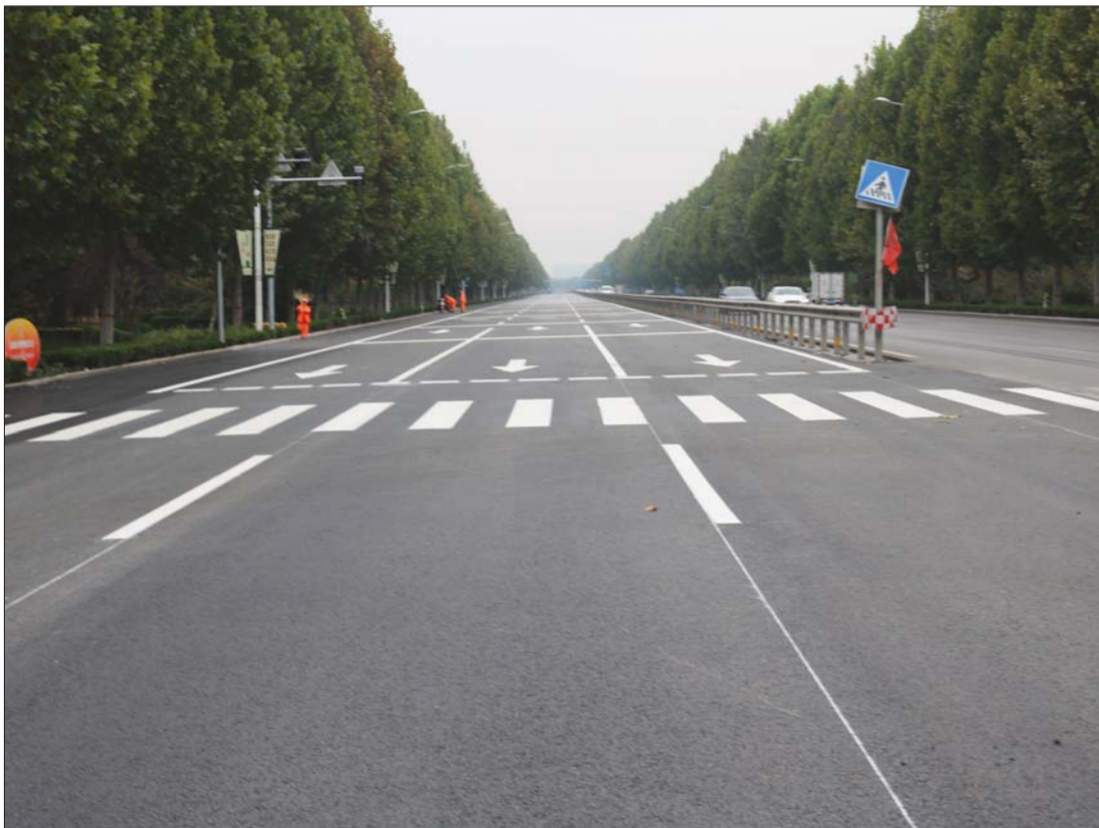
日兰高速济宁连接线恢复双向六车道通车。
